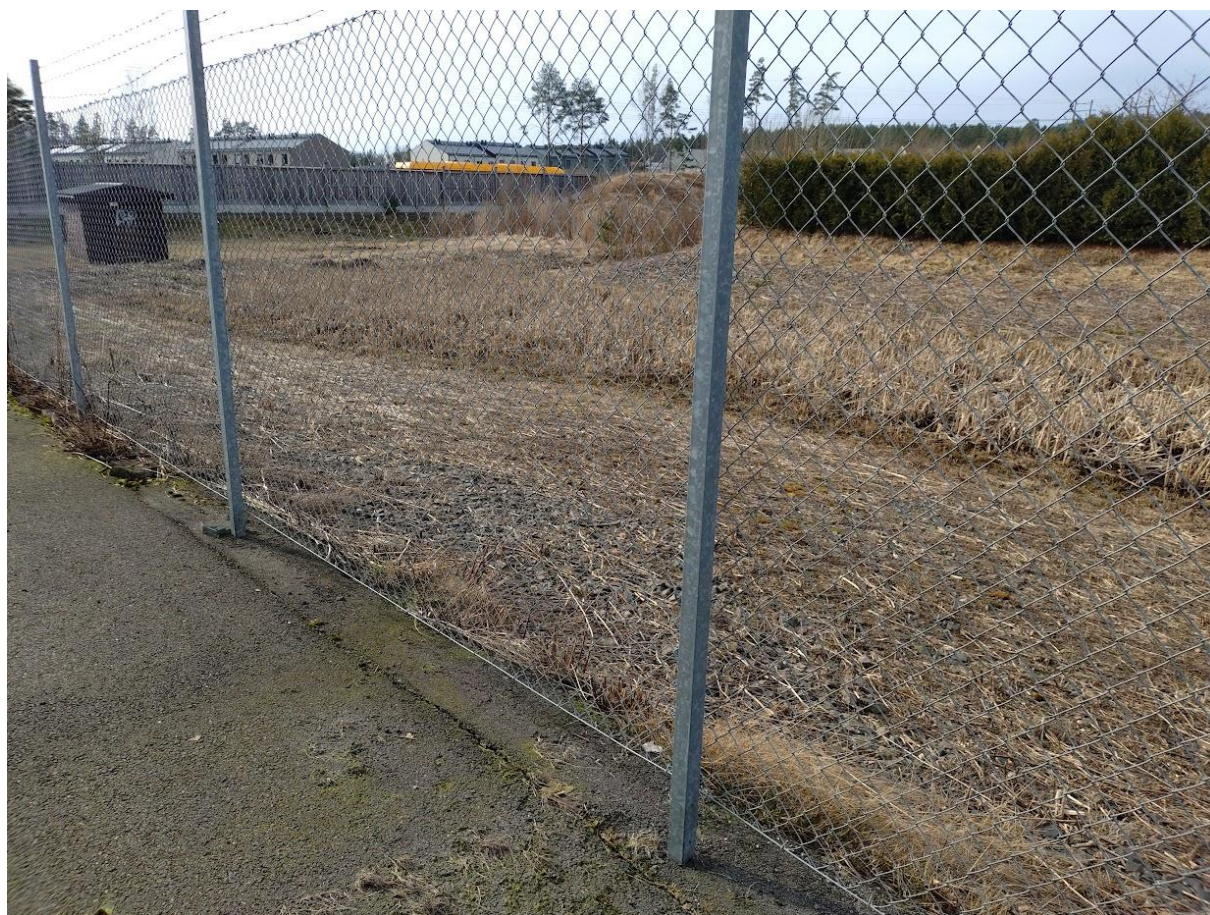
Bild 2; Fördröjningsmagasin väster om planområdet. I bakgrunden syns bullerplank och bullervall mot Lövnäsleden samt en pumpstation.
