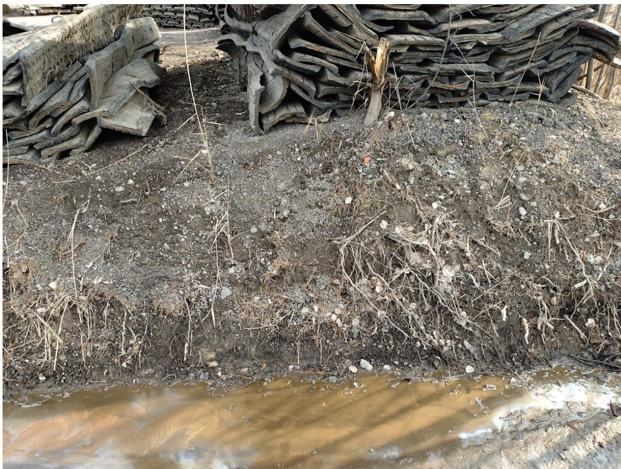
Bild 7; Skärningsslänt inom den östra delen av planområdet där sand förekommer under fyllning.
