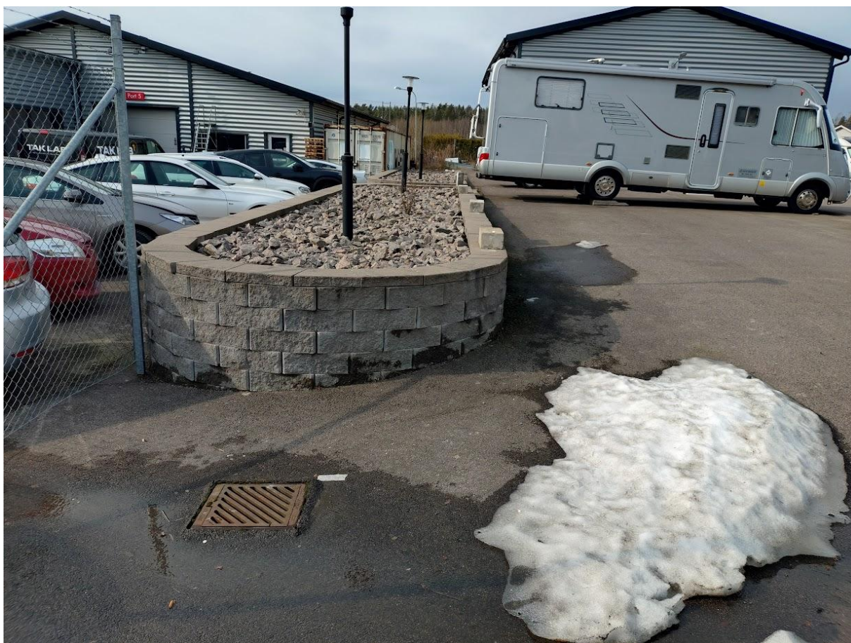
Bild 3; Stödmur mellan Hallersrud 1:97 och 1:98.
